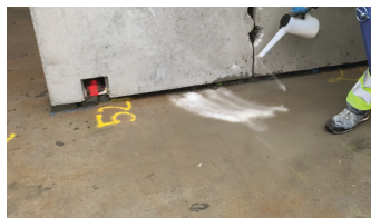
Vand ved elementerne
