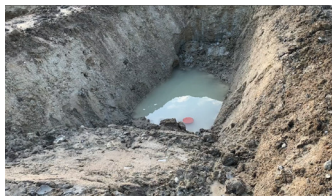
Udgravning med 1000 liter vand
